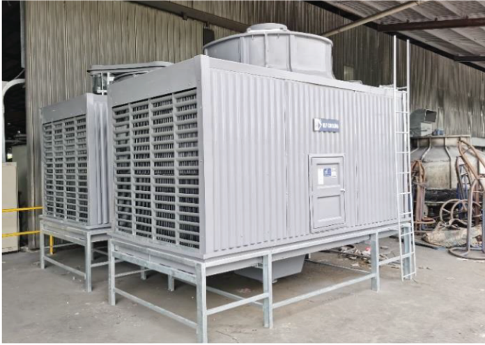
Wei Dat Steel Wire Sdn Bhd (Plant 1)
